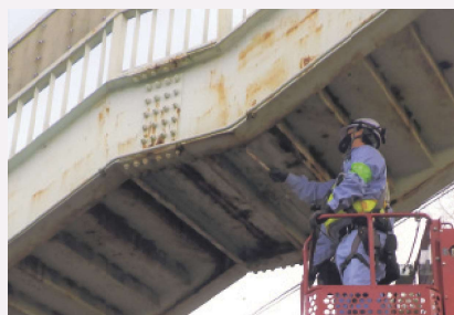
構造物の点検
