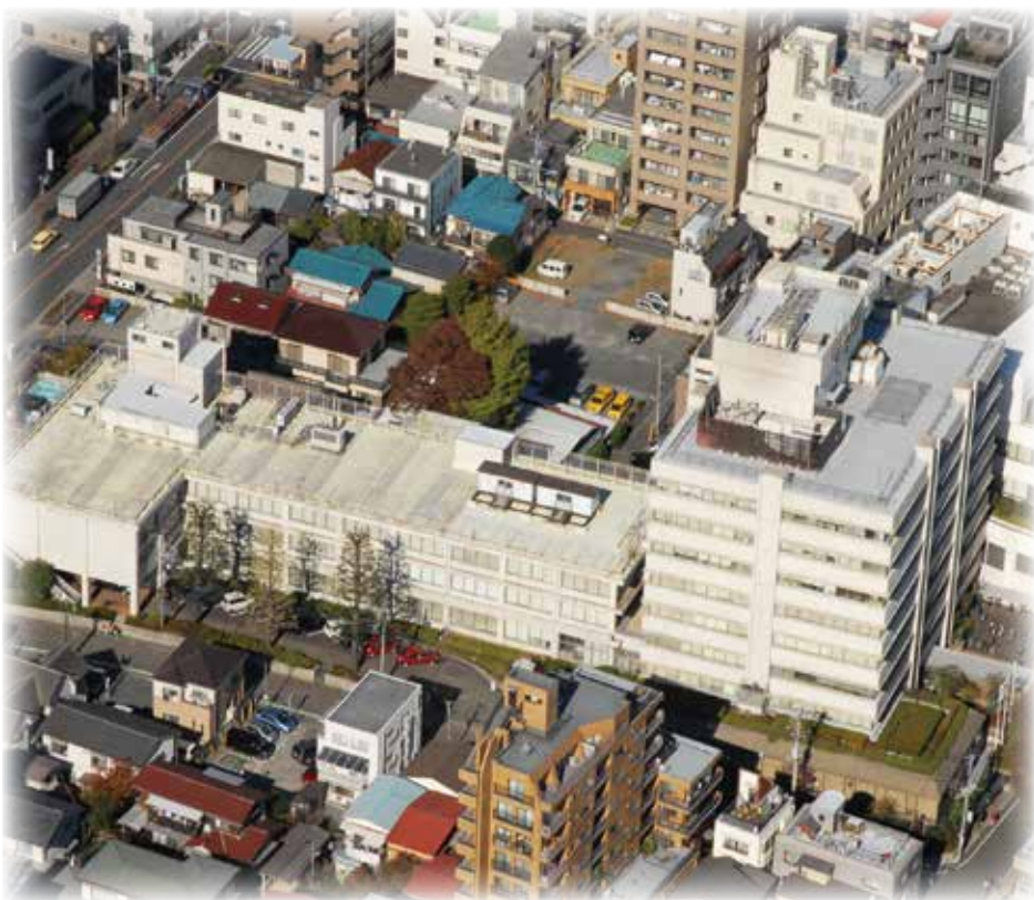
現在の府中市役所本庁舎
