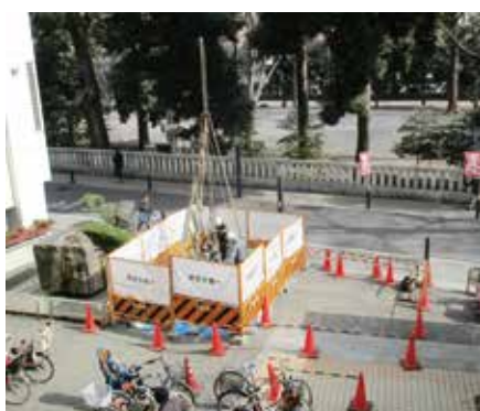
地盤調査の様子
