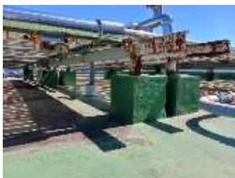
既設コンクリート基礎
