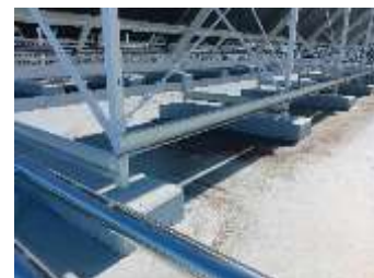
既存コンクリート基礎
