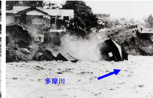
多摩川ニヶ領宿河原堰付近堤防決壊状況
