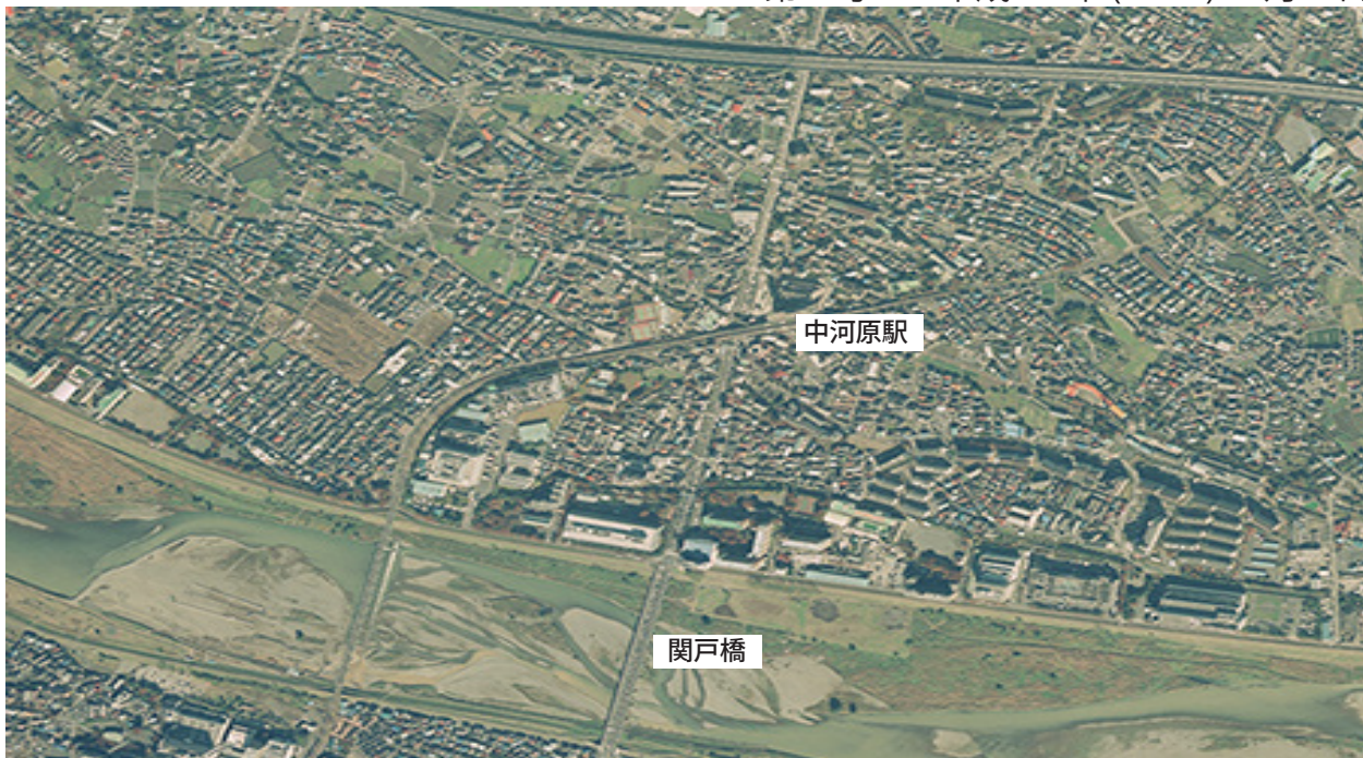
上空からみた中河原駅周辺
