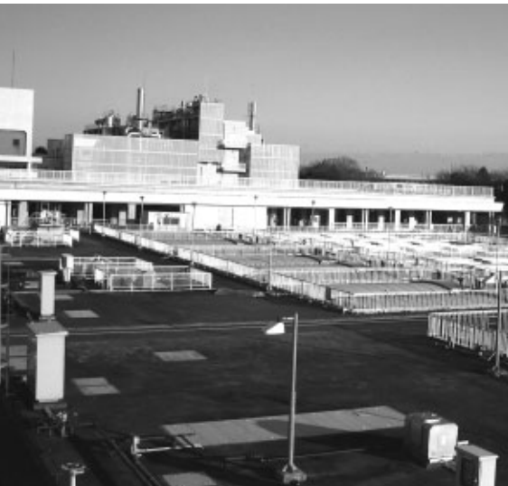
▲北多摩一水再生センター
