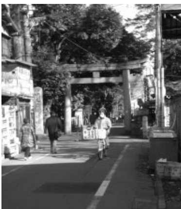
▲市道4-50号 他 矢崎町2丁目地内観月橋通り拡幅整備について
