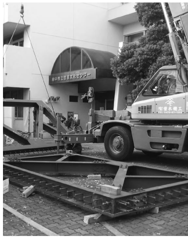
▲耐震工事(住吉文化センター)
