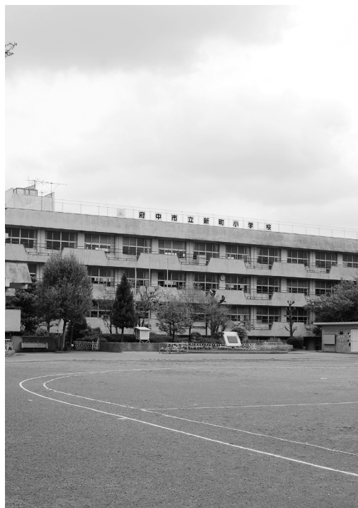
▲耐震化工事が予定されている新町小学校
