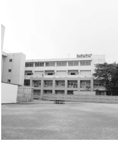
▲耐震工事中の市立若松小学校
