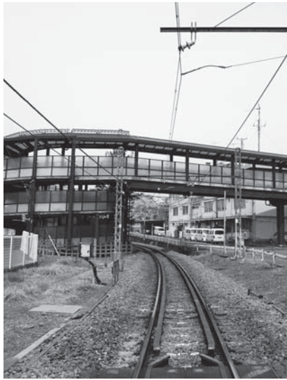
▲府中本町跨線橋
