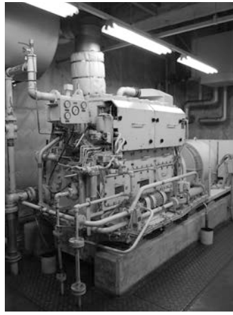
▲市役所内非常用発電設備 他 立川断層帯地震による新被害想定に対応する市の震災対策の強化について
