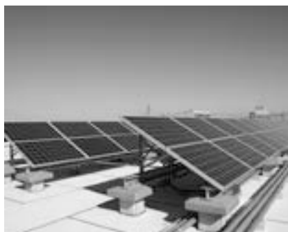
▲太陽光パネル(第五中学校)
