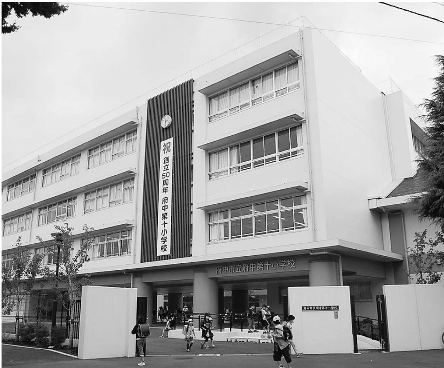
▲平成24年度に第十小学校と第五中学校が改築されました(写真:第十小学校)
