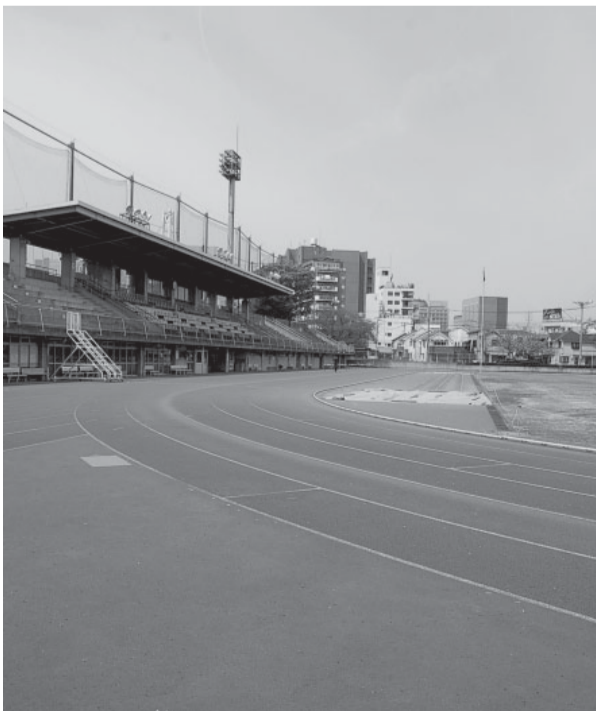
▲改修が予定される市民陸上競技場
