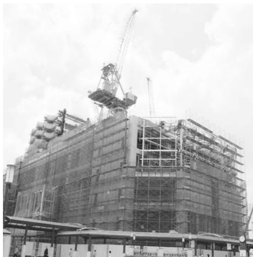
▲建設中の府中駅南口再開発ビル
