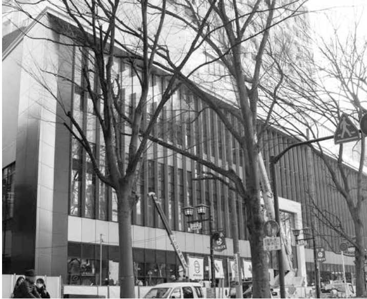
●建設中の府中駅南口再開発ビル
