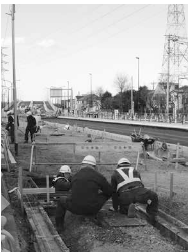
▲整備が進む新府中街道
