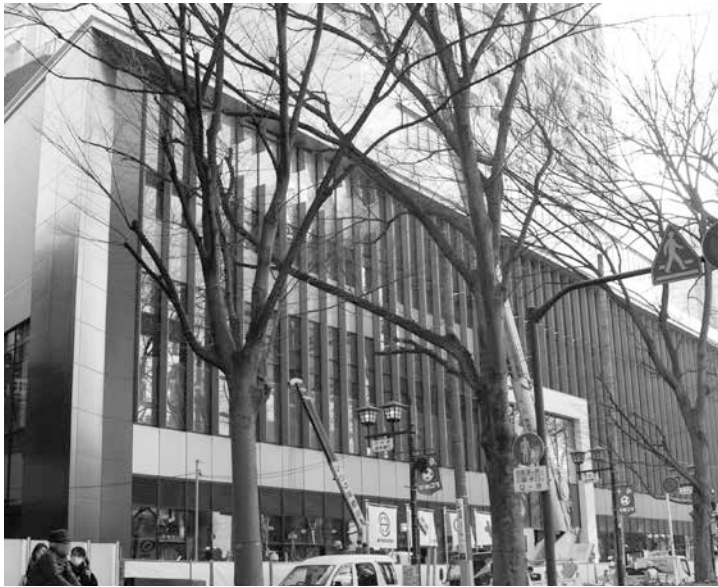
●建設中の府中駅南口再開発ビル
