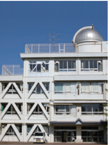
▲老朽化対策が必要な学校施設
