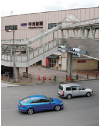
▲中河原駅北歩道橋周辺
