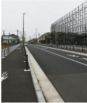
▲整備が進む都市計画道路3・4・11号(府中11号)の整備の進捗状況は。都市整備部長 16号の一期区間は一部を交通開放して、二期区間は設計に係る関係機関との協議を予定している。府中11号は用地の取得状況を見極め、整備の準備を進める。
