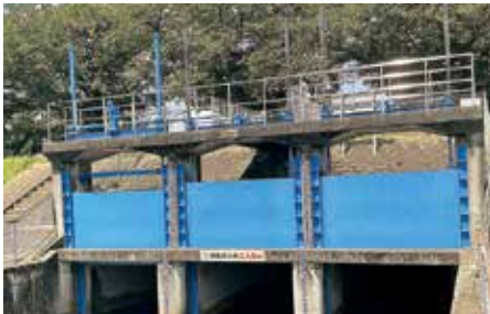
▼是政排水樋管(上)と矢崎都市下水路吐口(下)
