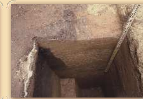
▲掘り込み地業の状況
