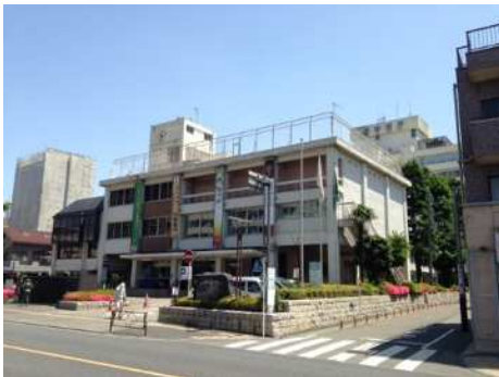
現庁舎(府中街道側から)
