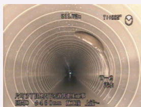
老朽化対策工事施工後
