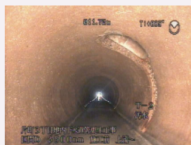
老朽化対策工事施工前
