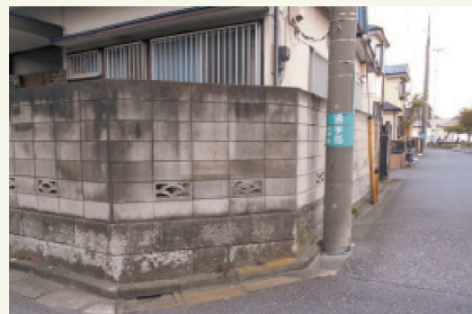
ブロック塀改修(施工前)
