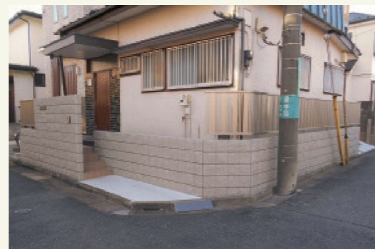
ブロック塀改修(施工後)
