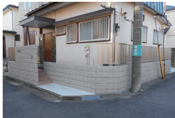
ブロック塀改修(施工後)
