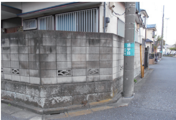
ブロック塀改修(施工前)
