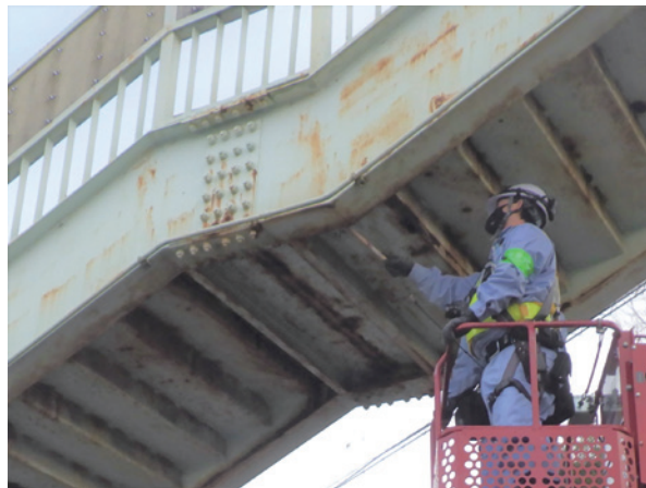
構造物の点検
