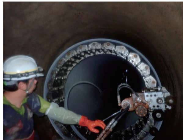
下水道管更生工事の様子
