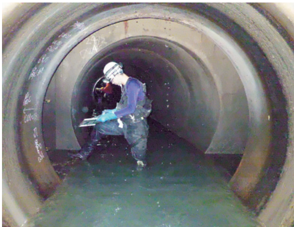
下水道管調査の様子
