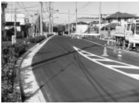
▶ 拡幅改修を行った市道31-100号
