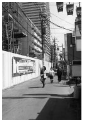
▲電線の地中化を行う都市計画道路7・5・1号
