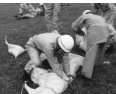
▲浸水を防ぐ積み土のう工法
