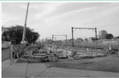
▲平成20年度末の開業に向け進められる西府駅建設工事
