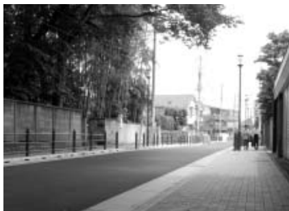
▲バリアフリー化された京所道
