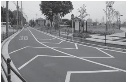
▲拡幅されたふるさと通り
