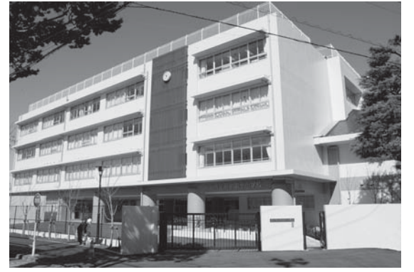
▲改築工事が完了した十小の校舎
