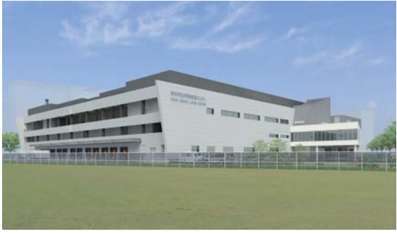
平成29年度2学期からの供用開始を予定しています
