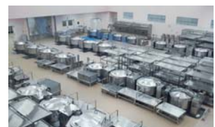
▲見学通路から見た煮炊調理室
