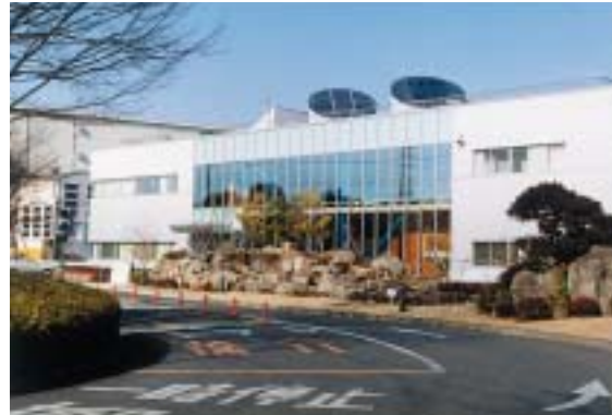
リサイクルセンター屋上 太陽光発電設備
