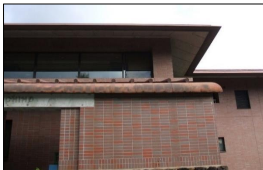
本館の屋根 経年による塗装の剥がれ
