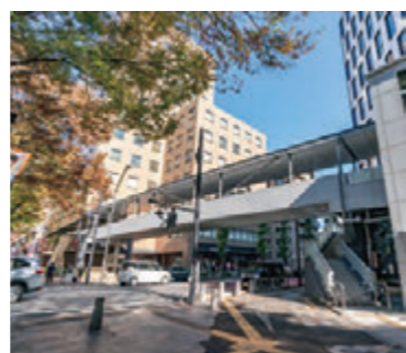
府中スカイナード歩道橋
