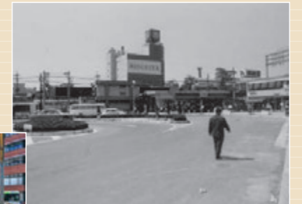
昭和49年 府中駅北口ロータリー
