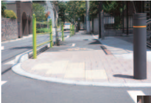
勾配を少なく平坦にした歩道
