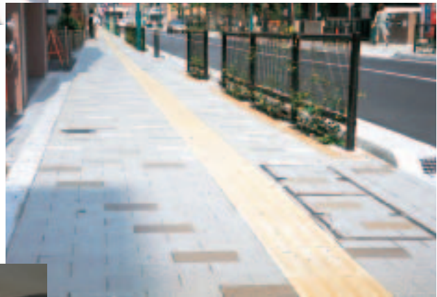
視覚障害者誘導用ブロックを連続して敷いた歩道
