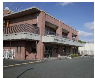
水害時の現地指揮本部機能を有 する水防・防災ステーション
