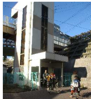
車いすや自転車の昇降を支援するエレベーターの設置
