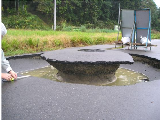
液状化によるマンホールの浮上
