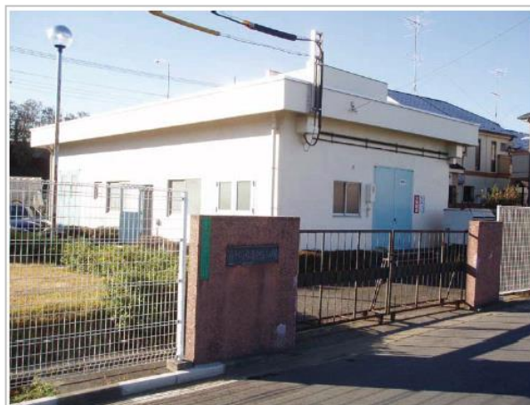
図 3-2-15-5 押立ポンプ場 外観
