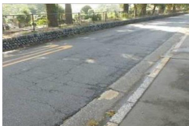
図3-2-3-6 MC I 値=3 ひび割れが面状にひろがり、わだちが顕著
