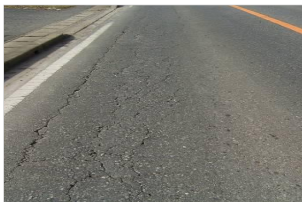
図3-2-3-5 MC I 値=3.5~4 ひび割れが複数ある程度
