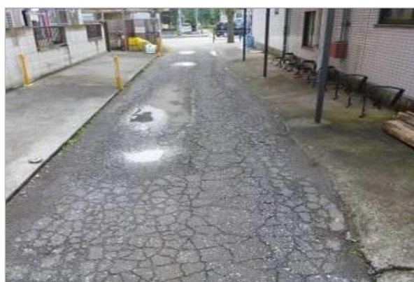
図3-2-3-7 MC I 値=2 ひび割れが全面にひろがり、わだち掘れが顕著
