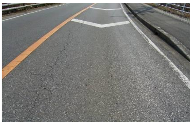
図3-2-3-4 MC I 値=5 ひび割れが見える程度
