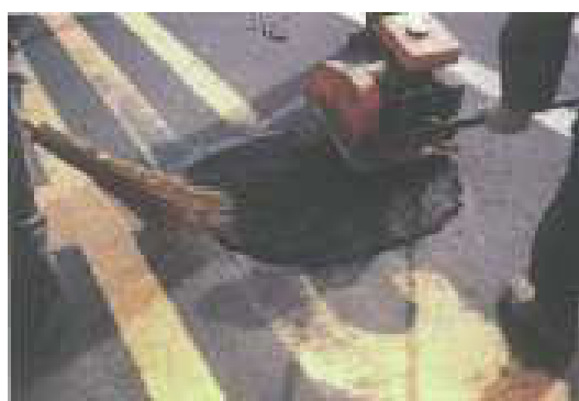
図 5-1-1-9 ポットホルの補修作業の例
