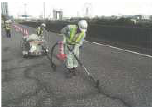
図 5-1-1-8 シール材充填作業の例
