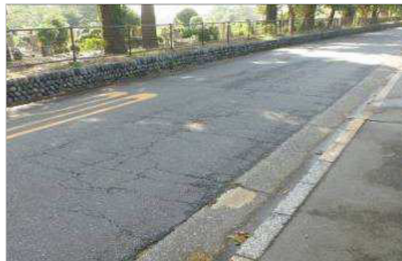
図 5-1-1-2 MCI 値=3 オーバーレイ工事 2 回ののちに、ひび割れが面状広がり、わだちが顕著になった場合に打換え工事をを行います。
