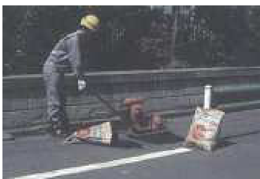
図 5-1-1-9 ポットホルの補修作業の例
