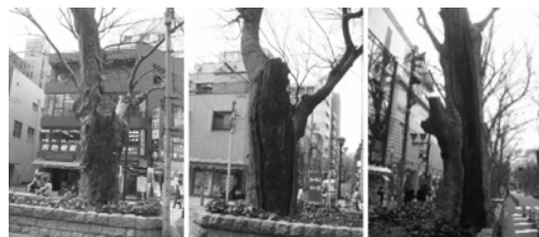
図 2-3-4 腐朽等の状況
