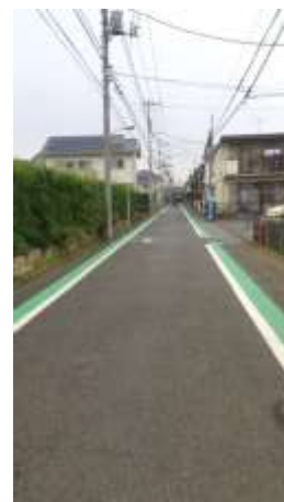
区画線及び路側帯カラー舗装
