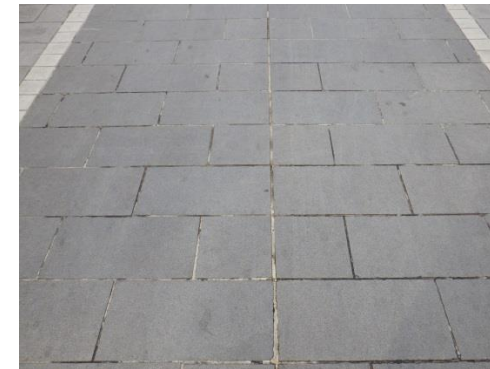
石張りの施工例（本町1丁目道路）
