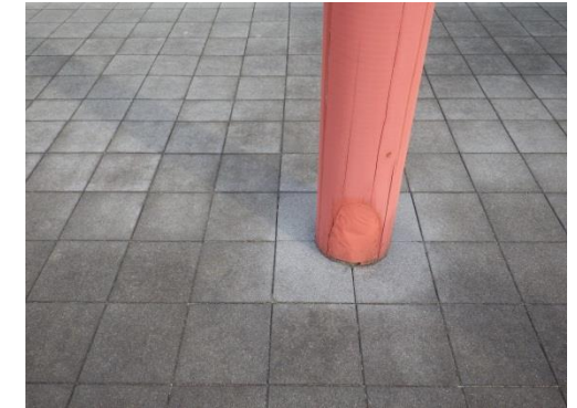
透水性インターロッキング施工例（国衙地区）
